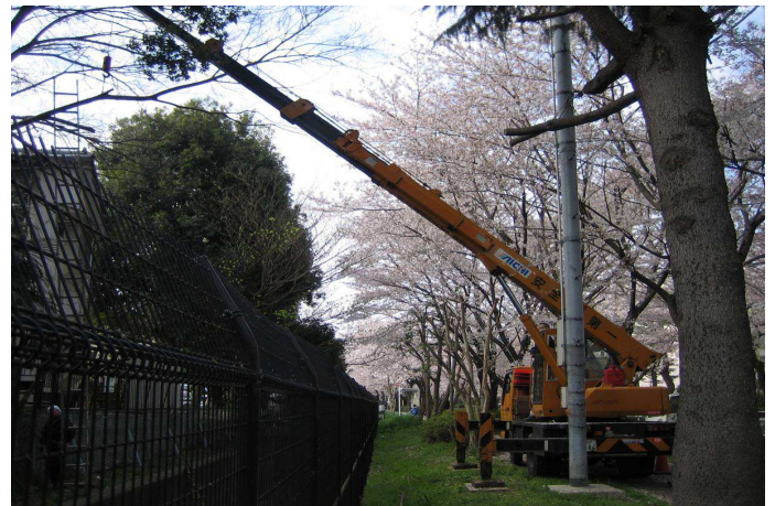
3tトラッククレーン 樹木の伐採（車重が軽い）
