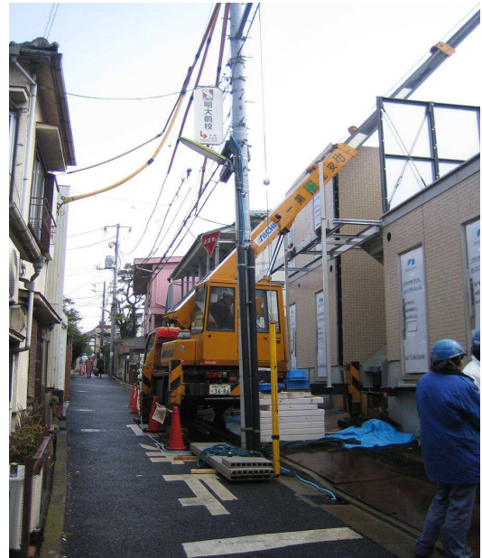
3tトラッククレーン 鉄骨建方（旋回が小さい）
